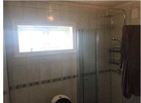
Bildet viser vindu i våtzone.
